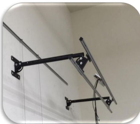
圖十一、將圖七黑色 A 端支架 套入圖十黑色 B 端支架套管
